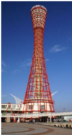
Гиперboloидная сетчатая башня в порту Кобе, Япония. 1963 год
